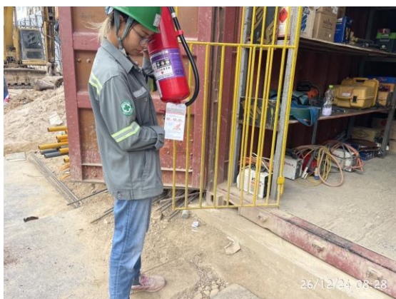
ภาพที่ 49 ดำเนินการตรวจสอบสภาพถังดับเพลิง
