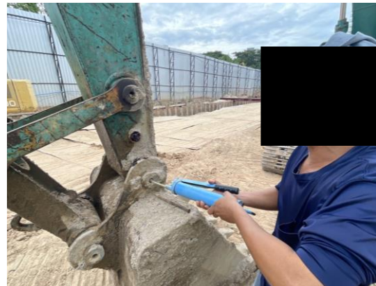
ภาพที่ 7 การซ่อมบำรุงเครื่องจักร
