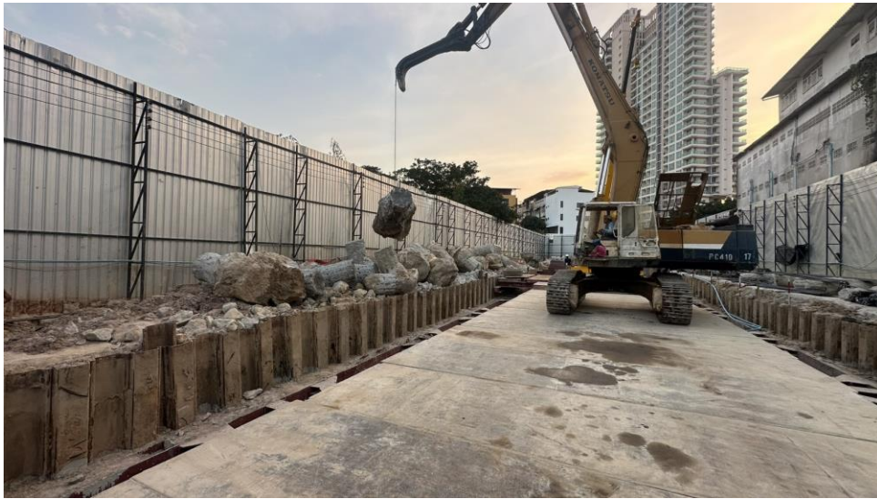
ภาพที่ 5 แนวผนังกันดินช่วงดำเนินการขุดเปิดหน้าดิน
